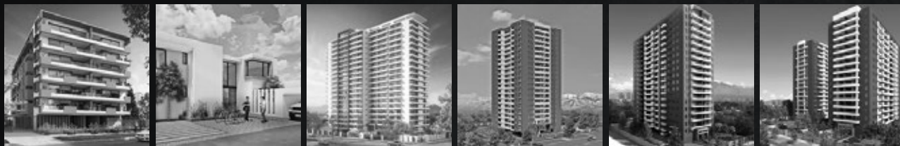
Edificio Acqua Providencia
